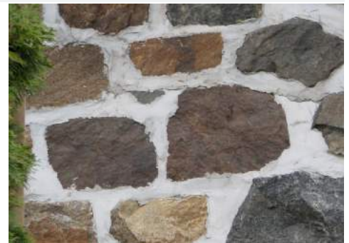
pierres naturelles avec joints de mortier
