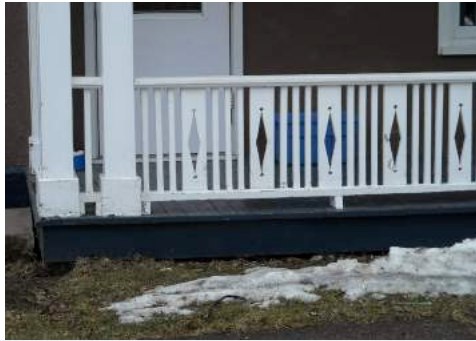
garde-corps à motifs
