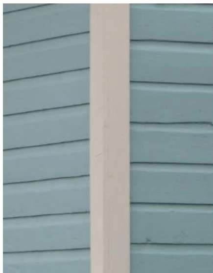
planches cornières de 100 à 150 mm (4 à 6 po) posées sur l'ensemble des coins
