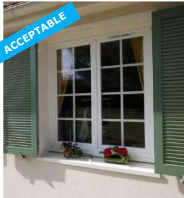
fenêtre en PVC avec carrelage entre les vitres
