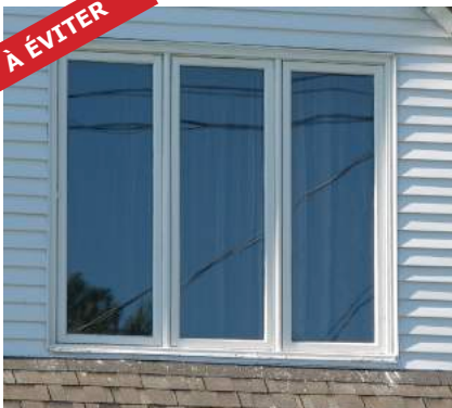
fenêtre sans encadrement
