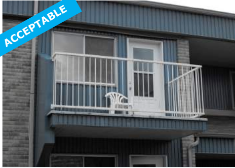
garde-corps en métal
