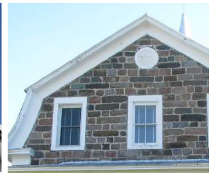
moulures sous les débords de toit
