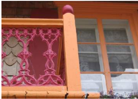
garde-corps moulé, en fonte
