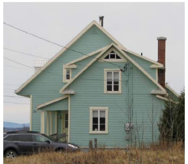
planches cornières de 100 à 150 mm (4 à 6 po) posées sur l'ensemble des coins
