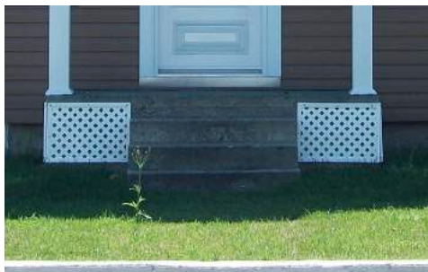
plancher et escalier en béton treillis en PVC blanc
