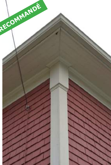
planches cornières moulurées et moulures sous les débords de toit
