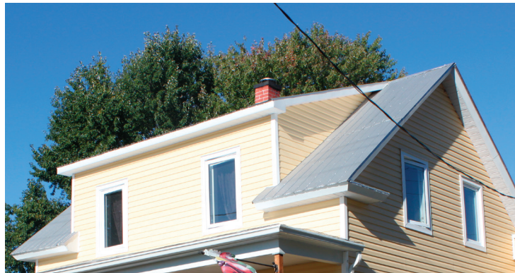
Lucarne rampante centrée sur le versant
