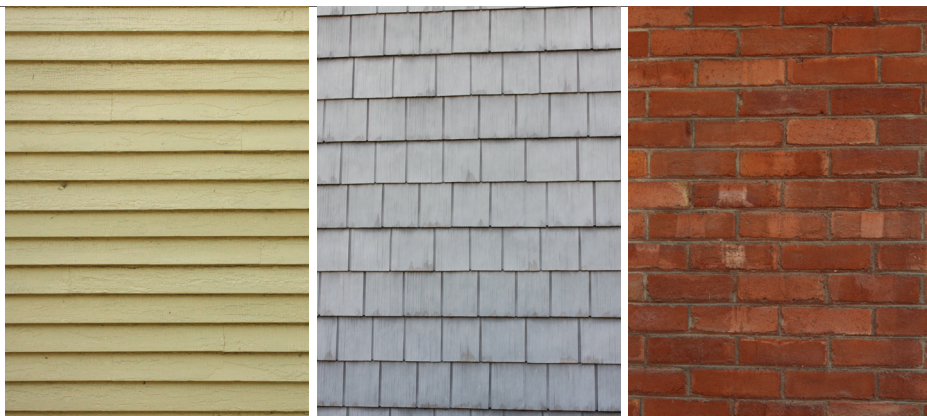
Revêtements muraux : planche de bois profilé à clin, bardeau de bois, brique d'argile
