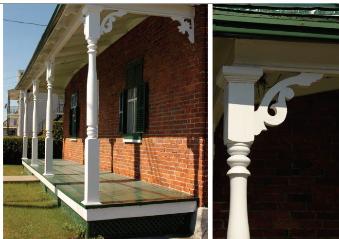
Grande galerie longeant la façade, ornementée de poteaux tournés et d'aiseliers en bois ouvragés
