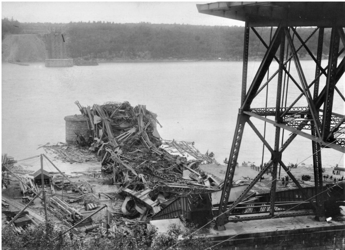
1b : le pont après son écroulement survenu en 1907. Un examen attentif de l'image permet de déceler la présence d'individus sur le site donnant un aperçu de la taille titanesque de l'ouvrage effondré.
